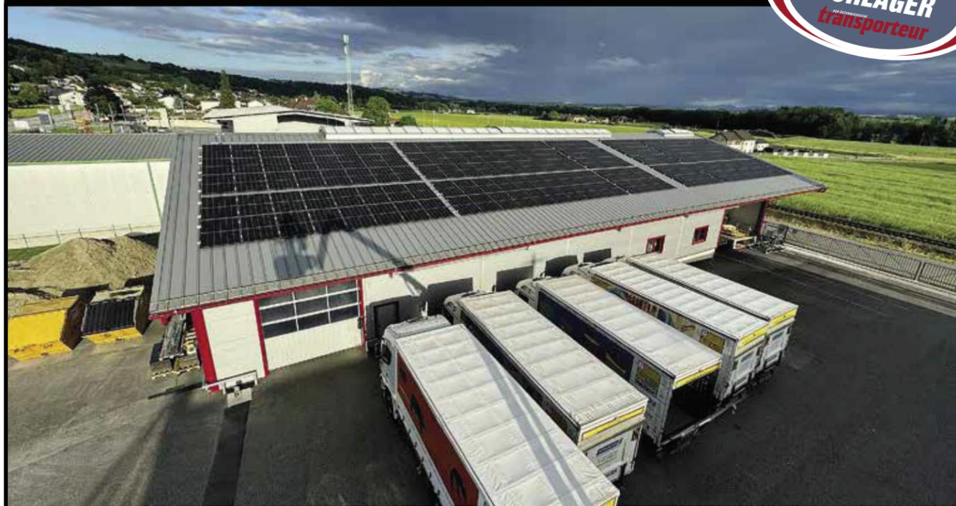
**AUFGERÜSTET** Die Photovoltaik-Anlage hat Schlager auf insgesamt 440 kWp (Kilowatt Peak) erweitert.
